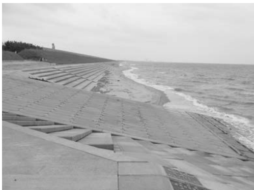
写真1 コンクリートで固められた海岸 (中条町 2005.5.15)
