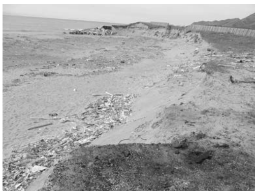
写真4 波に浸食された海岸 (寺泊町 2005.5.8)
